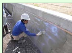
水路の補修・更新
