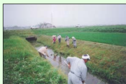
水路の泥上げ
