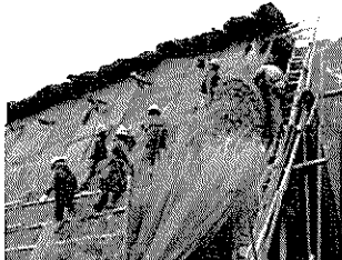
観光資源である古民家の茅葺き屋根の改修
