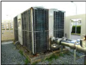
【老朽化した空調設備】
