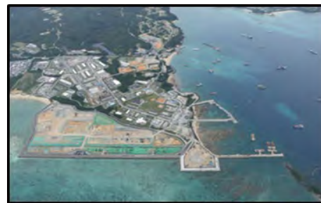
【普天間飛行場代替施設の建設】
