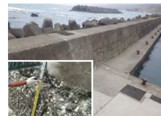
コンクリートの劣化・欠損
