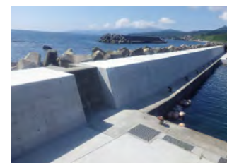
コンクリートを補修し、防波堤の耐用年数を延長
