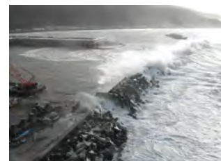
低気圧に伴う高波が防波堤を越波
