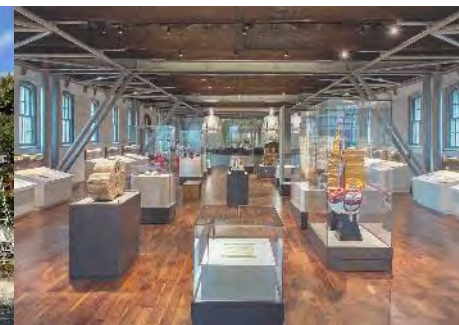
耐震補強イメージ (R6実施 重要文化財 旧集成館機械工場) (鹿児島県鹿児島市)
