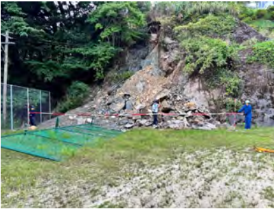
大雨被害による学校敷地内の法面崩落
