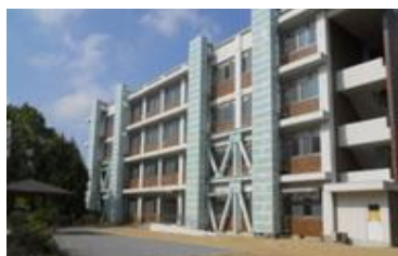
老朽改善された施設
