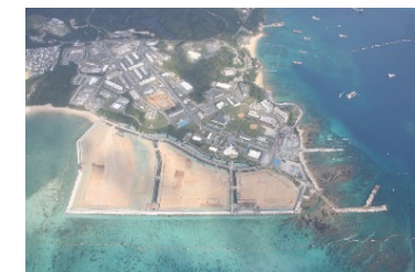
普天間飛行場代替施設の建設
