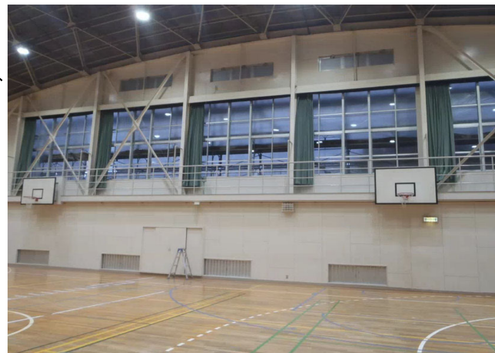
公立社会体育施設の構造化の耐震化イメージ (構造体に筋交い(ブレース)等を入れ耐震化を行う)
