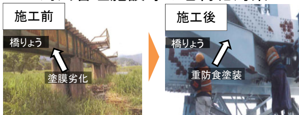
＜橋りょうの長寿命化に資する改良・補強事例＞
