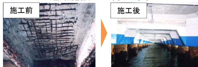
＜塩害により腐食した棧橋裏面の改良＞
