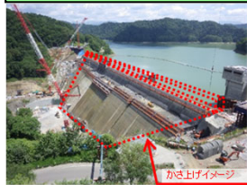
ダム建設・再生、既存ダム活用
