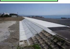
海岸保全施設整備
