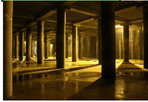
大規模地下貯留施設
