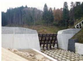
砂防関係施設整備
