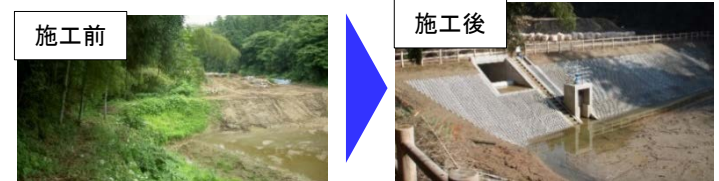
ため池の老朽化対策
