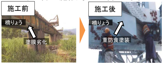
＜橋りょうの長寿命化に資する改良・補強事例＞ 鉄道施設の老朽化対策
