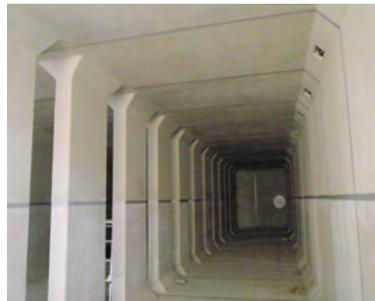
市街地に降った雨を一時的に貯留することにより、河川への流出を抑制し、内水浸水被害の防止・軽減を図る
