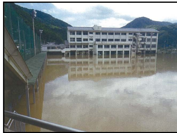
校庭浸水被害
