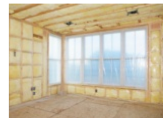
天井・壁等の 断熱改修工事
