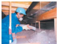
天井の断熱改修 (工事内容に応じ 2千～10万P)
