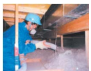
天井の断熱改修
