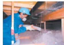
天井の断熱改修
