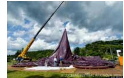
設置中の様子
