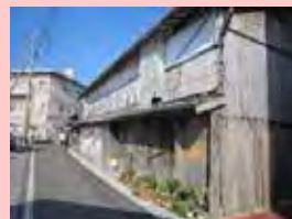
空き家の除却
