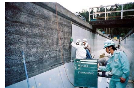
パネル接着工法
