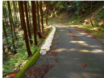
アスカーブ※の補修
