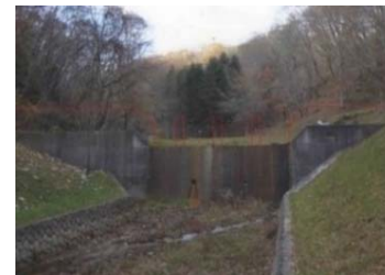
対策前の治山ダム
