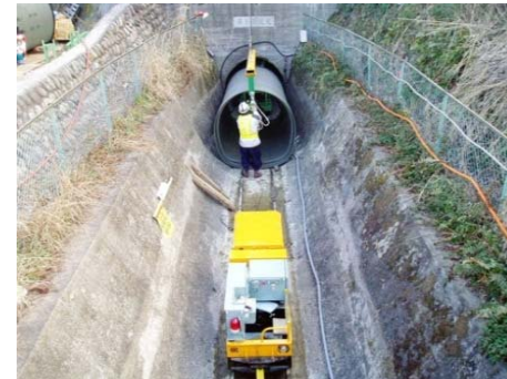
既成管挿入工法
