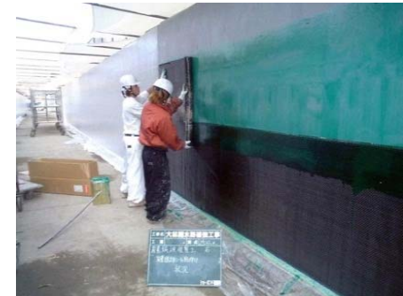
炭素繊維接着工法
