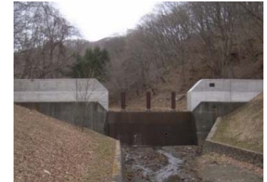
対策後の治山ダム
