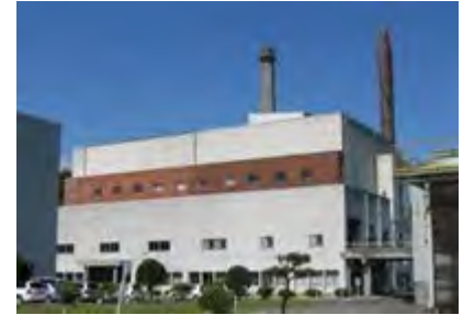
【ごみ焼却施設】
