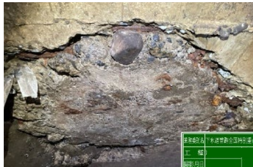
管の破損・クラックから緊急度Ⅰと判定
