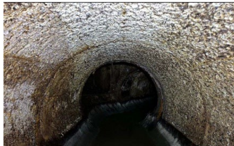
管の腐食から緊急度Ⅰと判定
