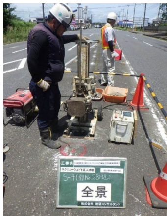
貫入試験による空洞調査
