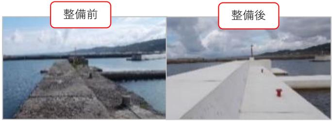
老朽化した岸壁のエプロン打ち直し
