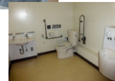
多目的トイレの整備
