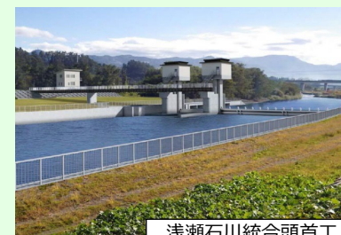
浅瀬石川統合頭首工
