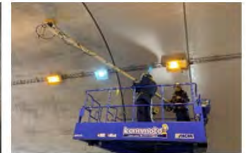
レーザーを利用した トンネル覆工の変状把握
