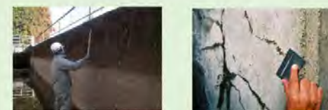
現状（目視による機能診断）
