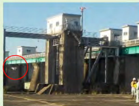
頭首工点検における UAV活用状況
