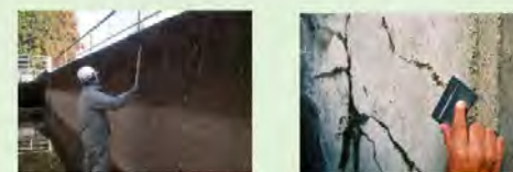
現状（目視による機能診断）
