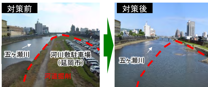
五ヶ瀬川の河川改修
