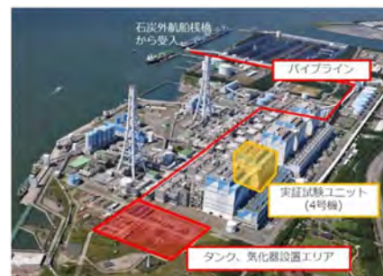
アンモニア混焼実証事業が行われる 愛知県碧南火力発電所 出典: JERA資料から国土交通省作成
