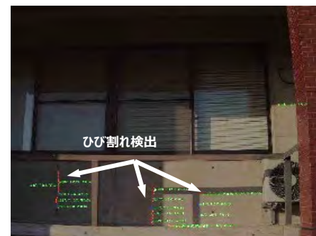
A I による判別結果の一例 (4 K カメラ画像を用いたひび割れ検出)
