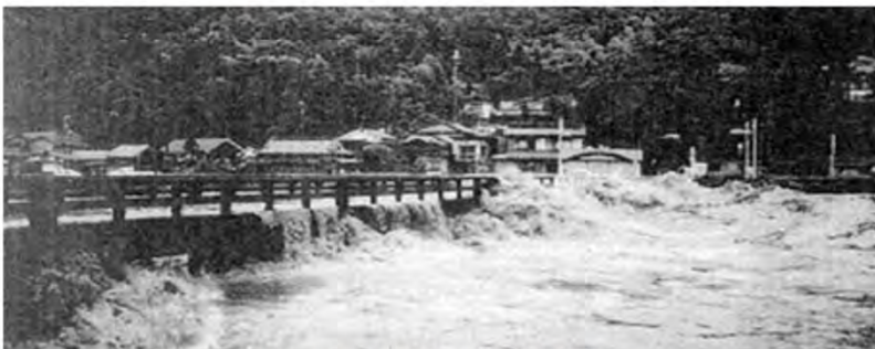
桁下高不足による支障事例
