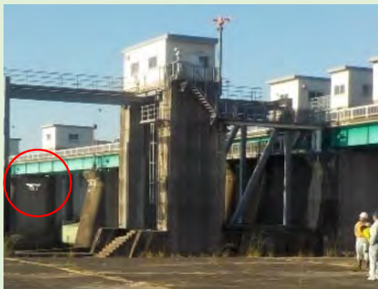
頭首工点検における UAV活用状況
