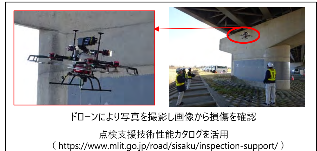
点検支援技術（H31～：2巡目点検）
