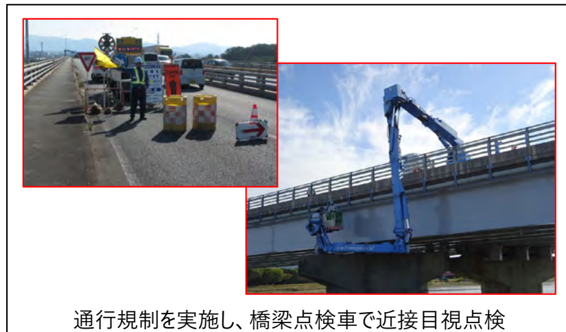
従来点検（H26～H30：1巡目点検）
