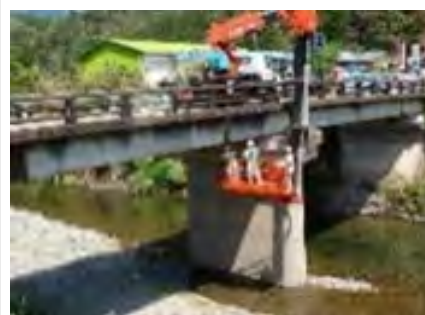
インフラの維持管理(点検作業)
