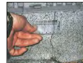
基礎のひび割れ幅の計測
