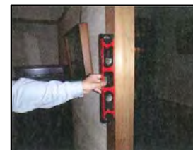
水平器による柱の傾きの計測
