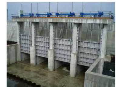
海岸保全施設(水門)
