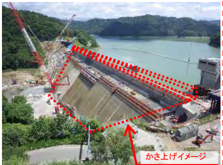
ダム建設・ダム再生
