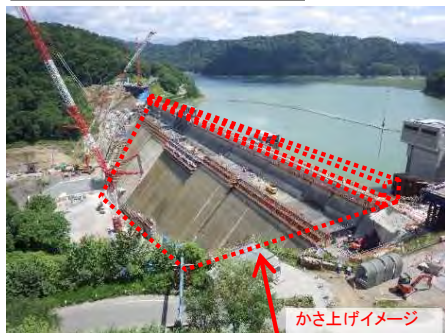
ダム建設・ダム再生
