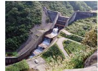
砂防施設(砂防堰堤)
