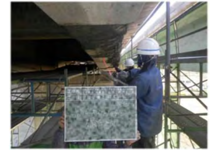
修繕の様子(断面修復)
