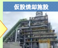
仮設焼却施設
