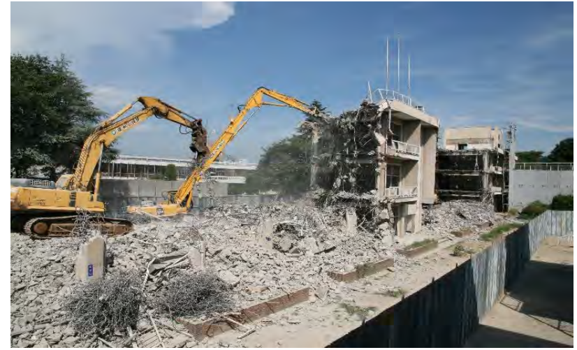
全壊となった第一小学校校舎の解体工事
