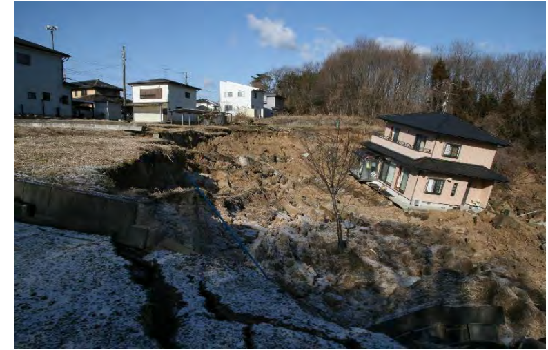
家が約 50m にわたり崩落
