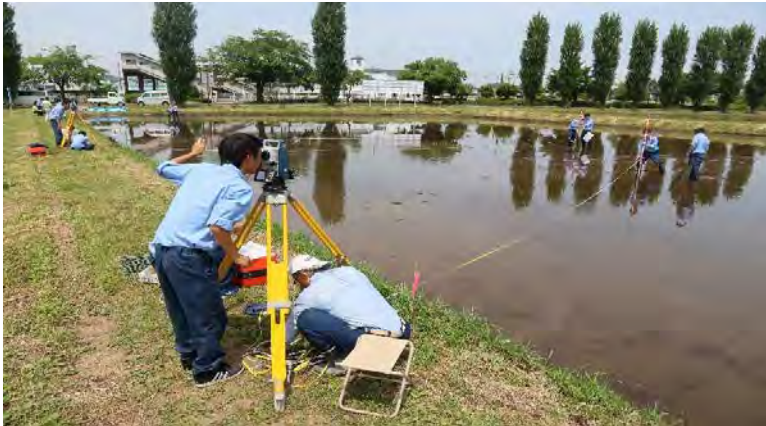
地元高校生による測量作業
