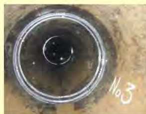
止水バンド工法による補修(予防保全)
