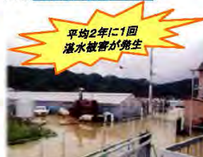
浸水被害の状況（H5）
