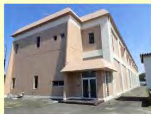
外壁のひび割れ補修、塗装、 屋根の防水処理(補修)
