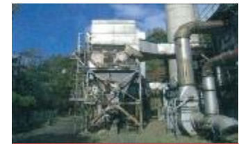
老朽化して休止した処理施設
