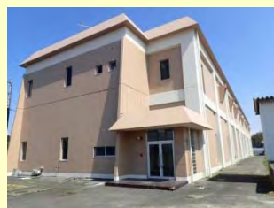
外壁のひび割れ補修、塗装、 屋根の防水処理(補修)
