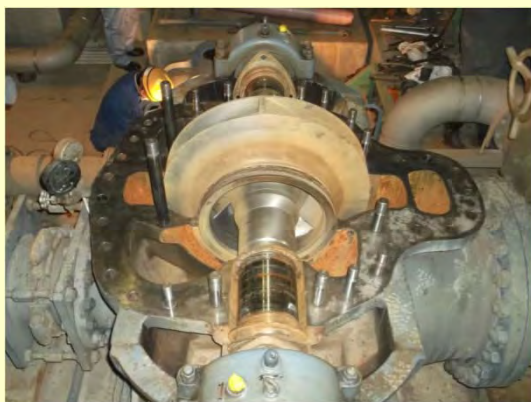
ポンプの分解整備
