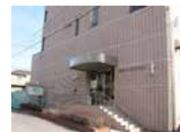
1992（平成4） 藤崎図書館
