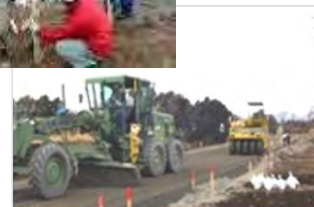
従来施工(丁張りによる施工)
