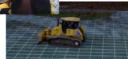
ICT建機による施工
