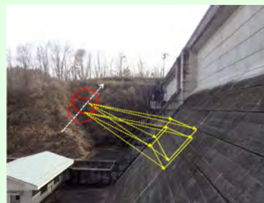
UAVを活用した 施設の点検状況
