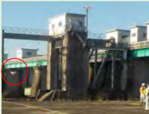
頭首工点検における UAV活用状況
