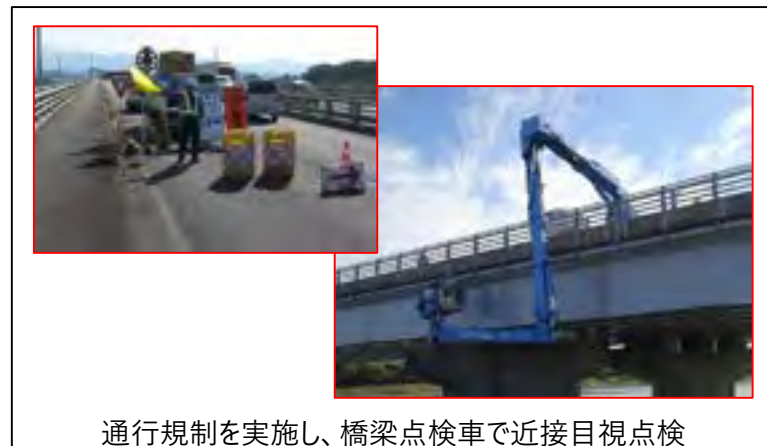
従来点検（H26～H30：1巡目点検）
