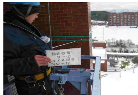
従来手法による外壁点検
