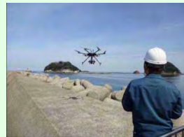
UAVを使用した作業状況
