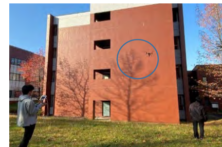
ドローンを活用した点検
