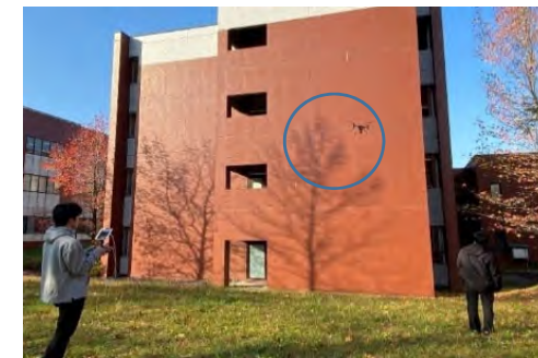
ドローンを活用した点検
