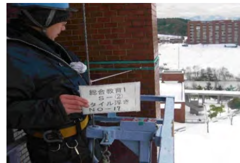
従来手法による外壁点検
