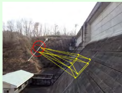
UAVを活用した 施設の点検状況
